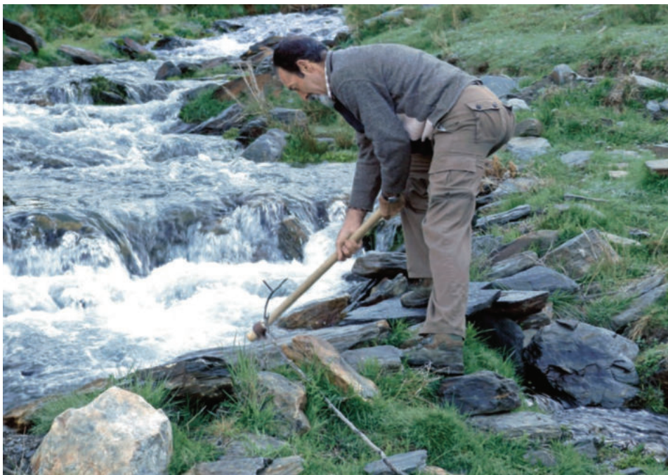
Lám. 2. Acequero de la Comunidad de Regantes de Bérchules arreglando la toma de la acequia del Espino. Foto: R. Espin.
