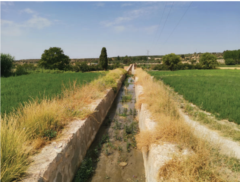
Lám. 6. Acequia que conduce al acueducto. Foto: Evaristo López López.
