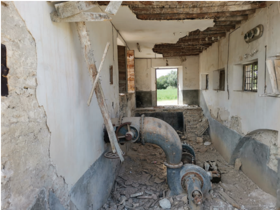
Lám. 7. Turbina que transformaba la fuerza del agua en fluido eléctrico. Foto: Evaristo López López.
