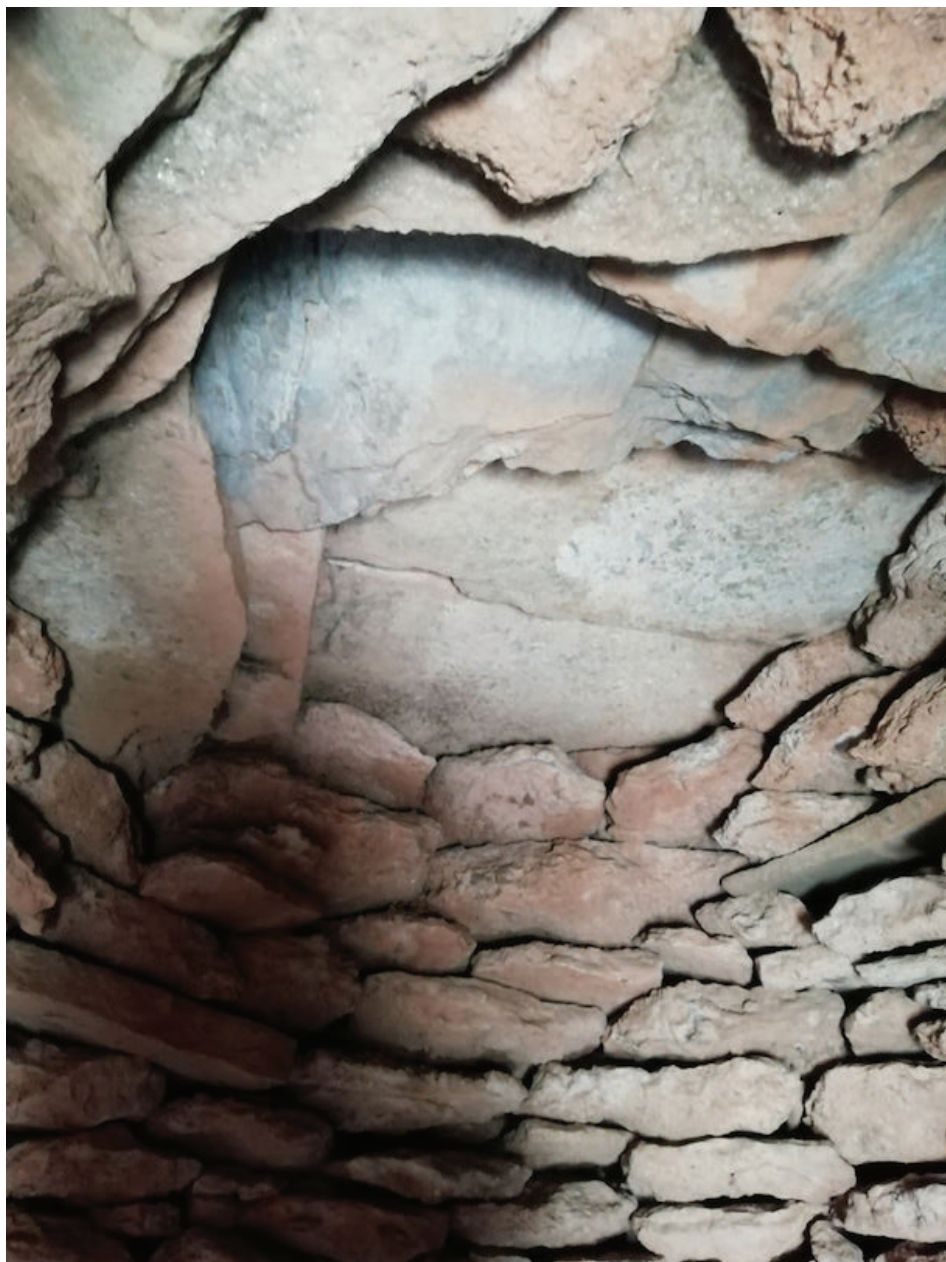
Lám. 4. Cerramiento en falsa bóveda de una casilla de Charches. Foto: A. Castillo López.
