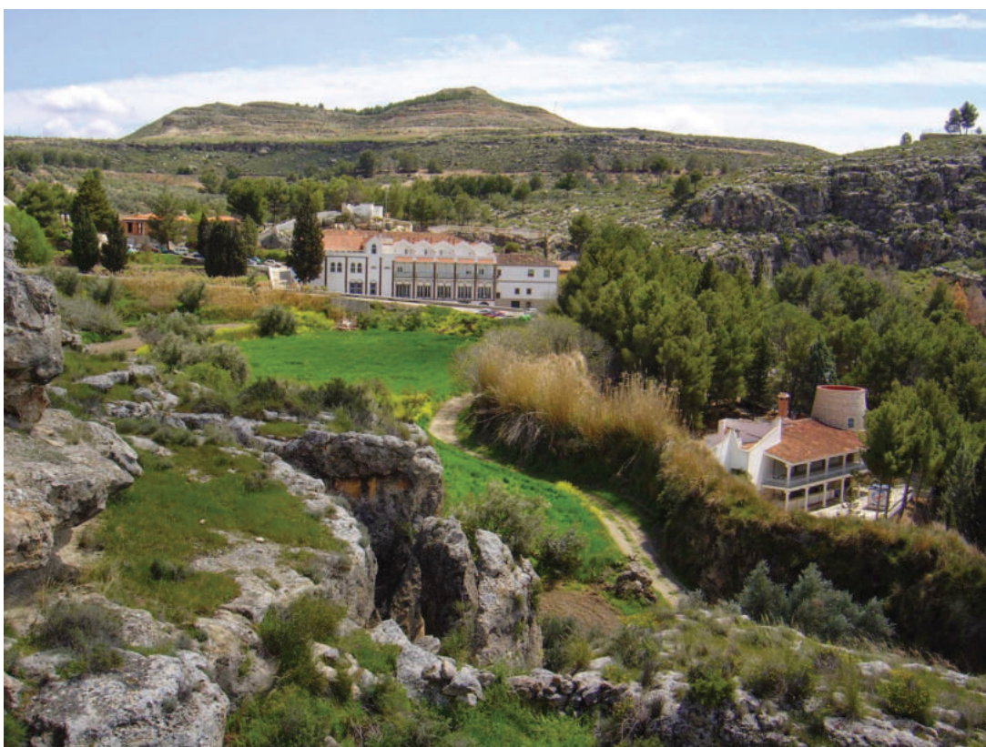
Lám. 6. Panorámica de las instalaciones del balneario de Alicún de las Torres.
