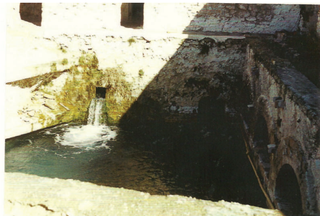
Lám. 4. Arquería S y manantial principal.
