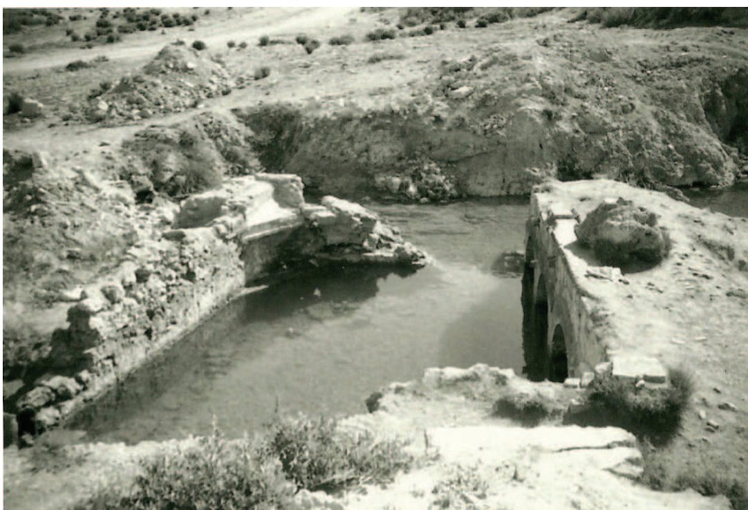
Lám. 3. Baño general de forma irregular.
