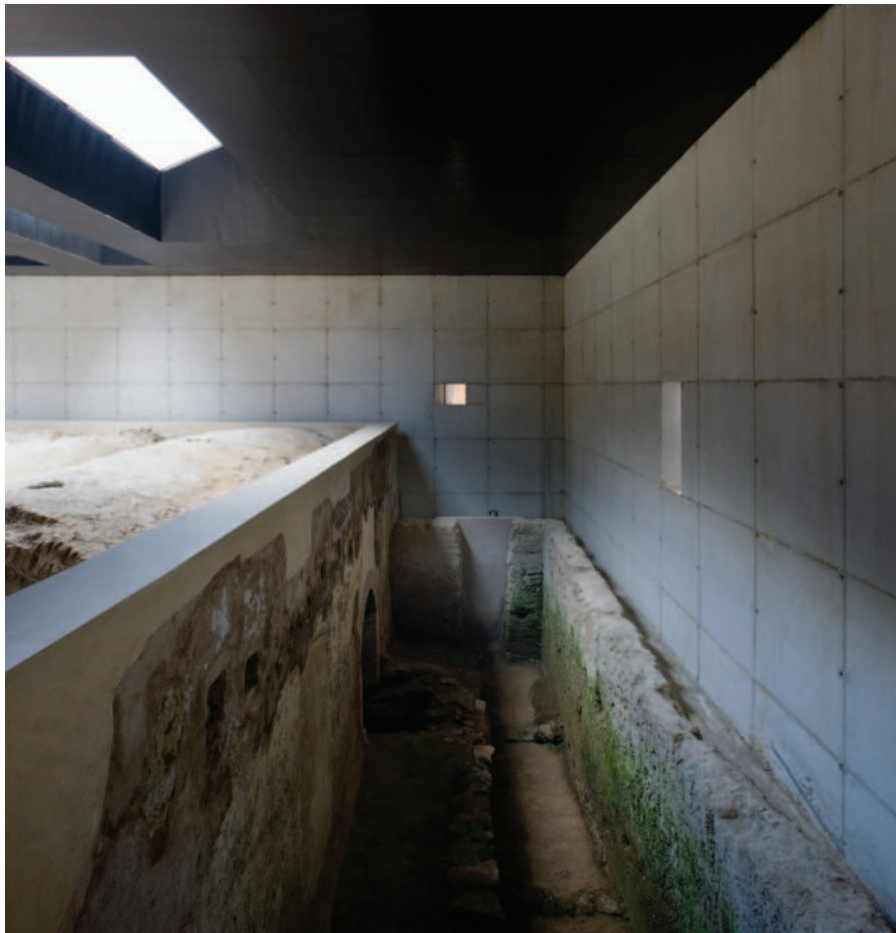
Lám. 5. Estructura de hormigón y cubierta de acero como envoltura de los baños. Foto: Fernando Alda.
