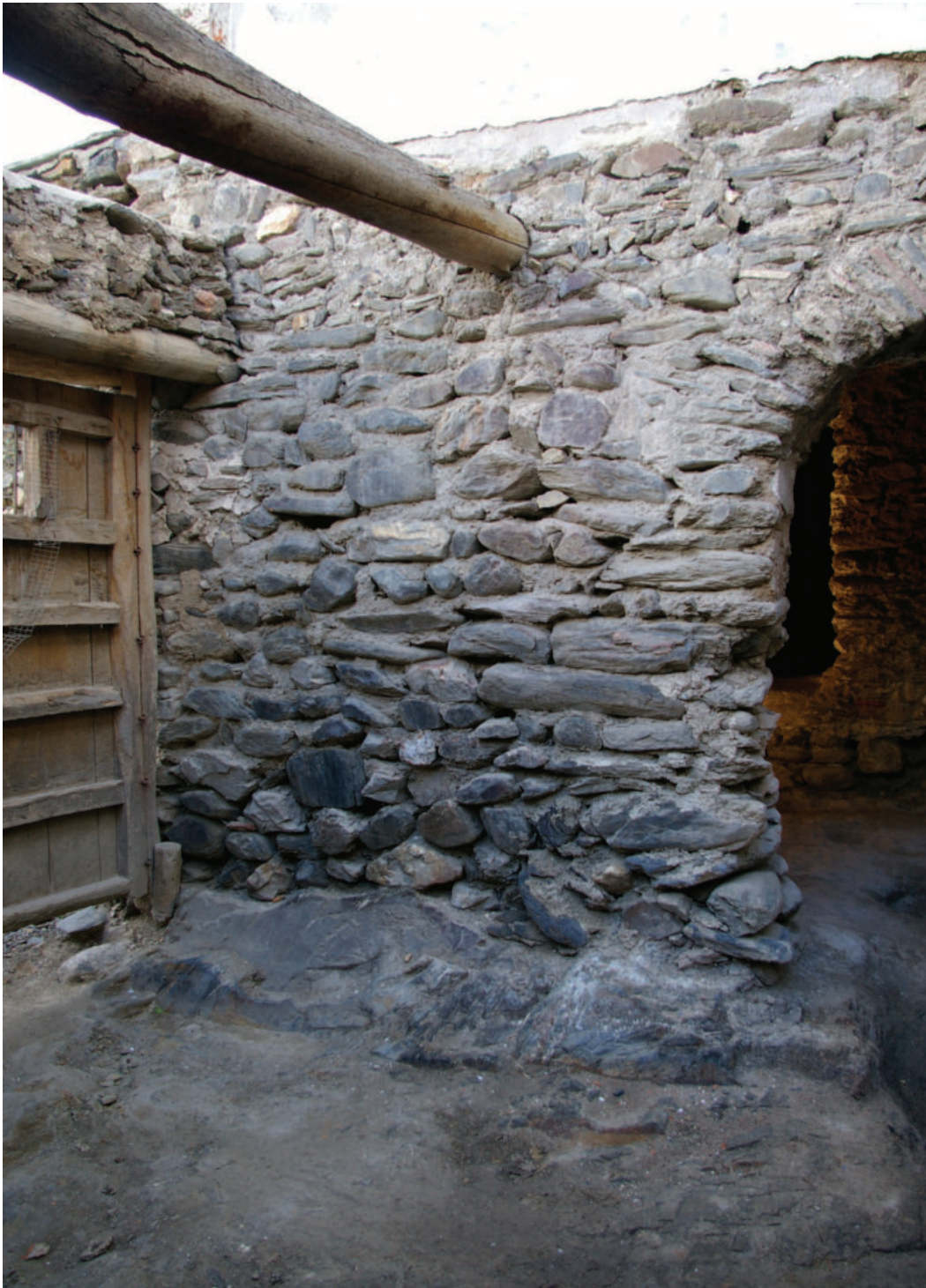
Lám. 26. Detalle de la adaptación de las estructuras de mampostería a la roca (frente oeste). Foto: José Javier Álvarez.
