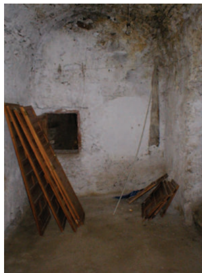
Lám. 5. Sala caliente antes de la intervención. Foto: José Javier Álvarez.
