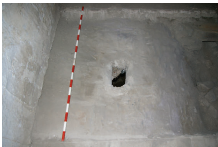
Lám. 25. Cubierta de la sala fría. Foto: José Javier Álvarez.
