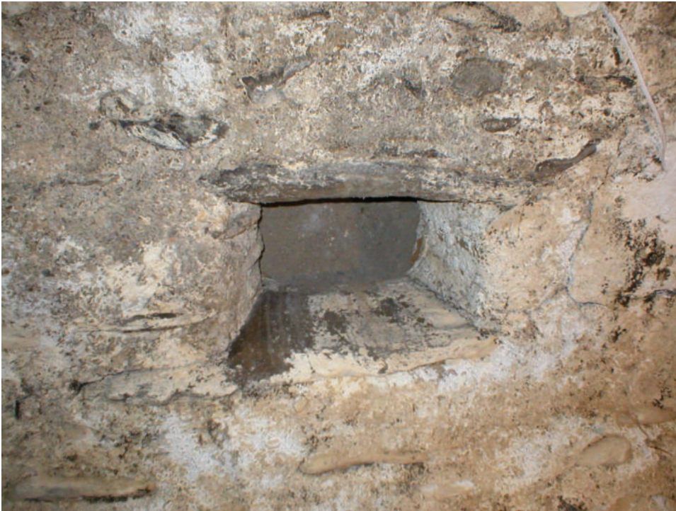
Lám. 7. Detalle de una de las lucernas de la sala fría. Foto: José Javier Álvarez.
