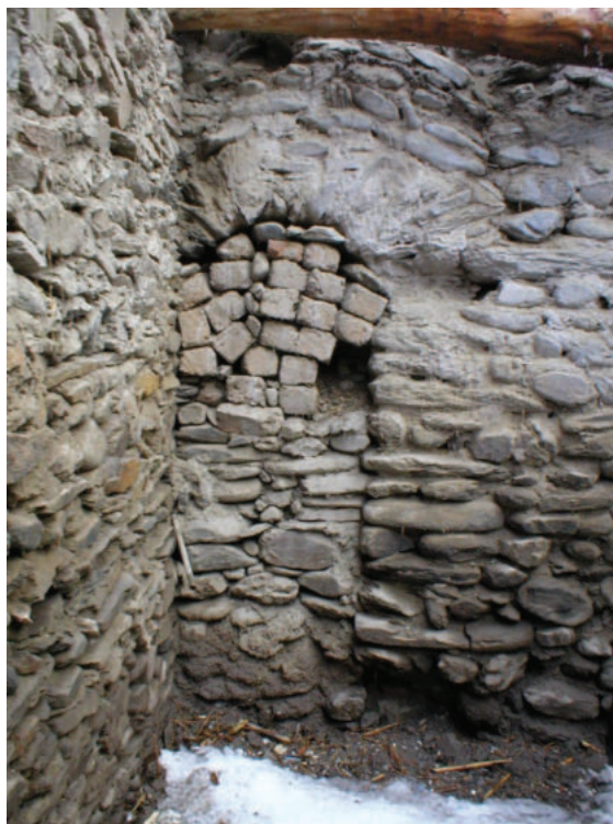
Lám. 3. Detalle del cerramiento del vano de acceso a la sala fría desde el frente norte. Foto: José Javier Álvarez.
