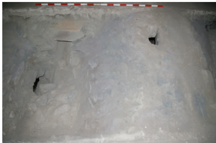
Lám. 24. Cubierta de la sala templada. Foto: José Javier Álvarez.
