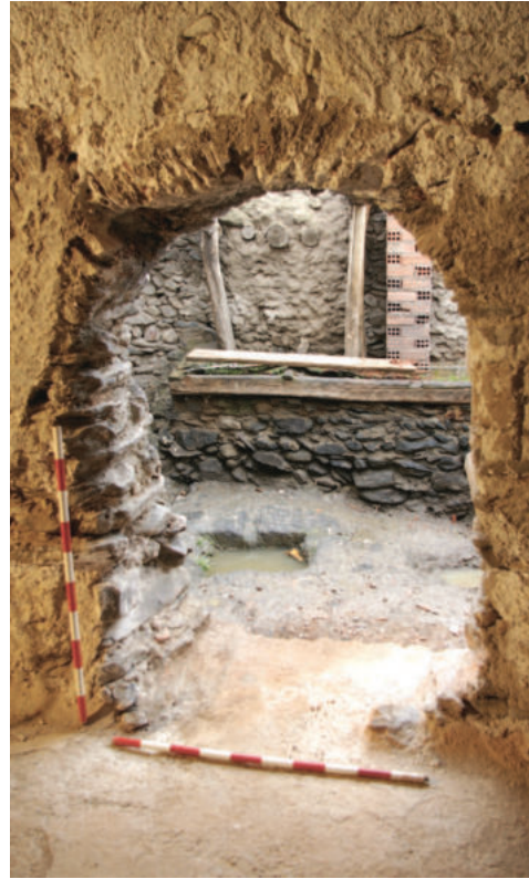
Lám. 17. Detalle del vano desde el interior. Foto: José Javier Álvarez.
