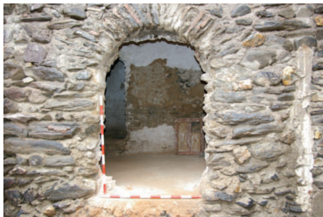
Lám. 18. Detalle del vano desde el exterior. Foto: José Javier Álvarez.
