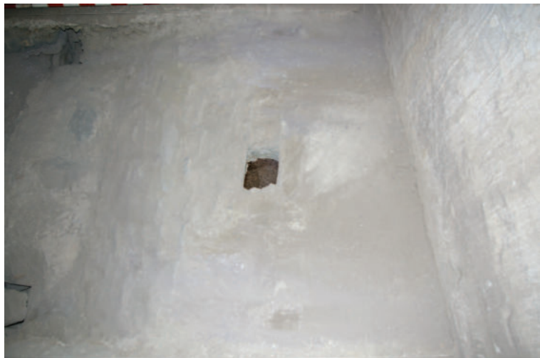
Lám. 23. Cubierta de la sala caliente. Foto: José Javier Álvarez.
