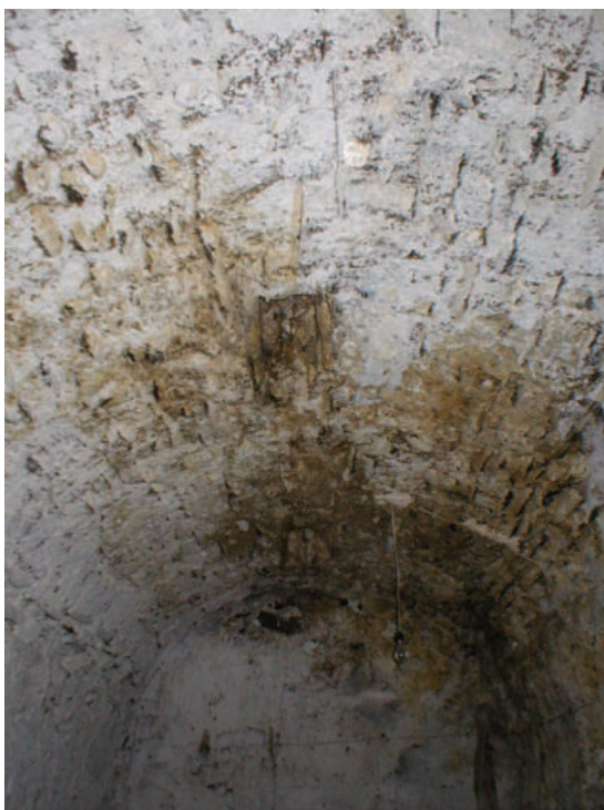
Lám. 15. Detalle de la bóveda y de los restos de hollín que no han sido cubiertos por el encalado. Foto: José Javier Álvarez.
