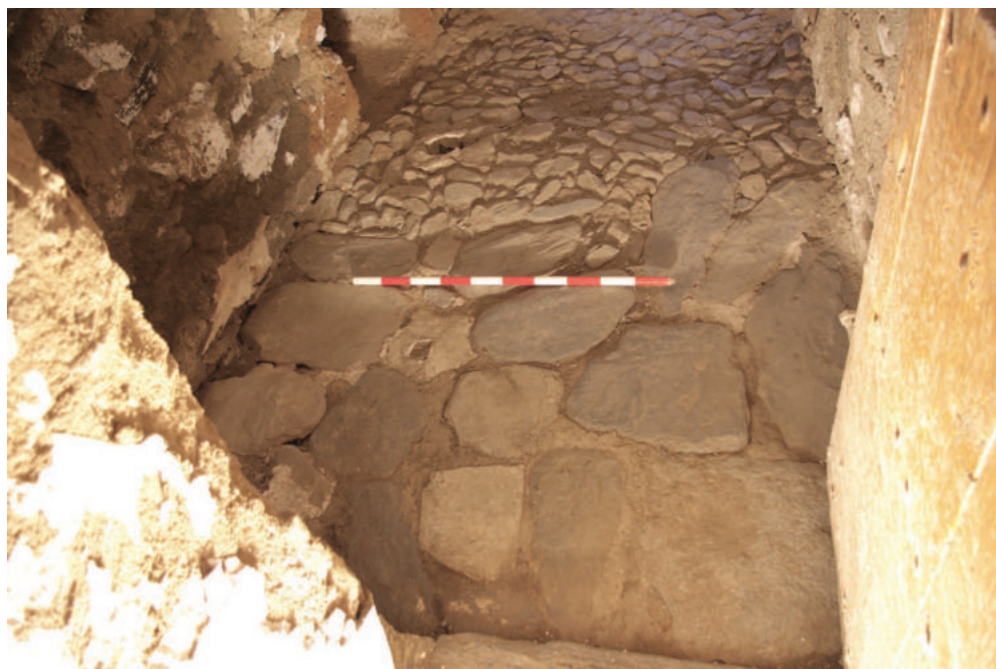
Lám. 8. Detalle de los pavimentos que amortizan los niveles inferiores del baño.
