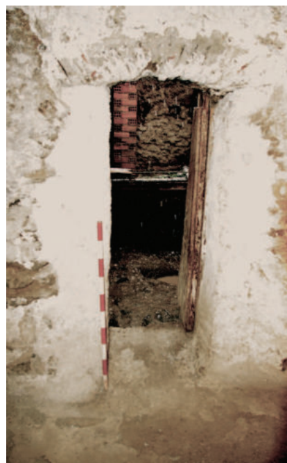
Lám. 13. Vista del vano situado en el testero oeste de la sala caliente desde el interior. Foto: José Javier Álvarez.
