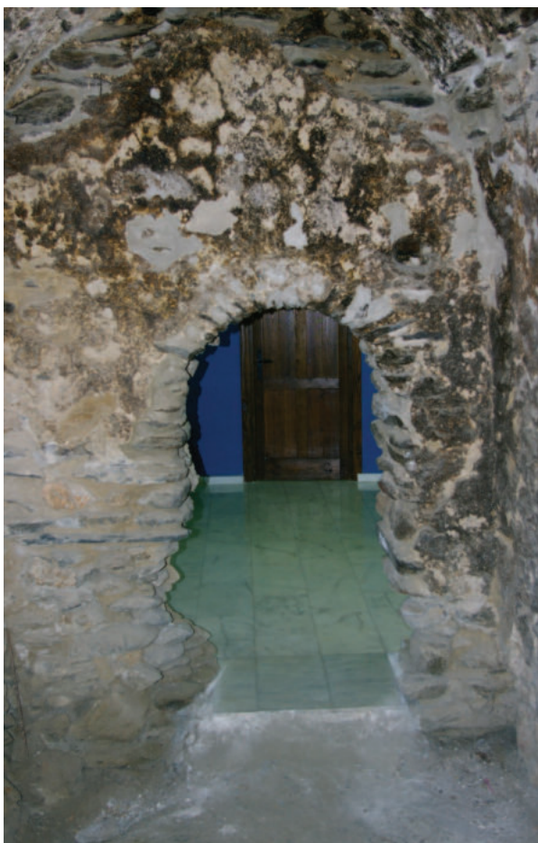
Lám. 17. Puerta que comunica la sala fría con el vestíbulo
