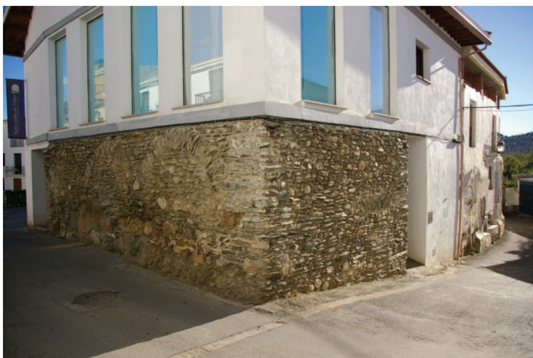
Lám. 14. Vista oeste y sur del baño al que se sobrepone el Centro de Interpretación del Agua.
