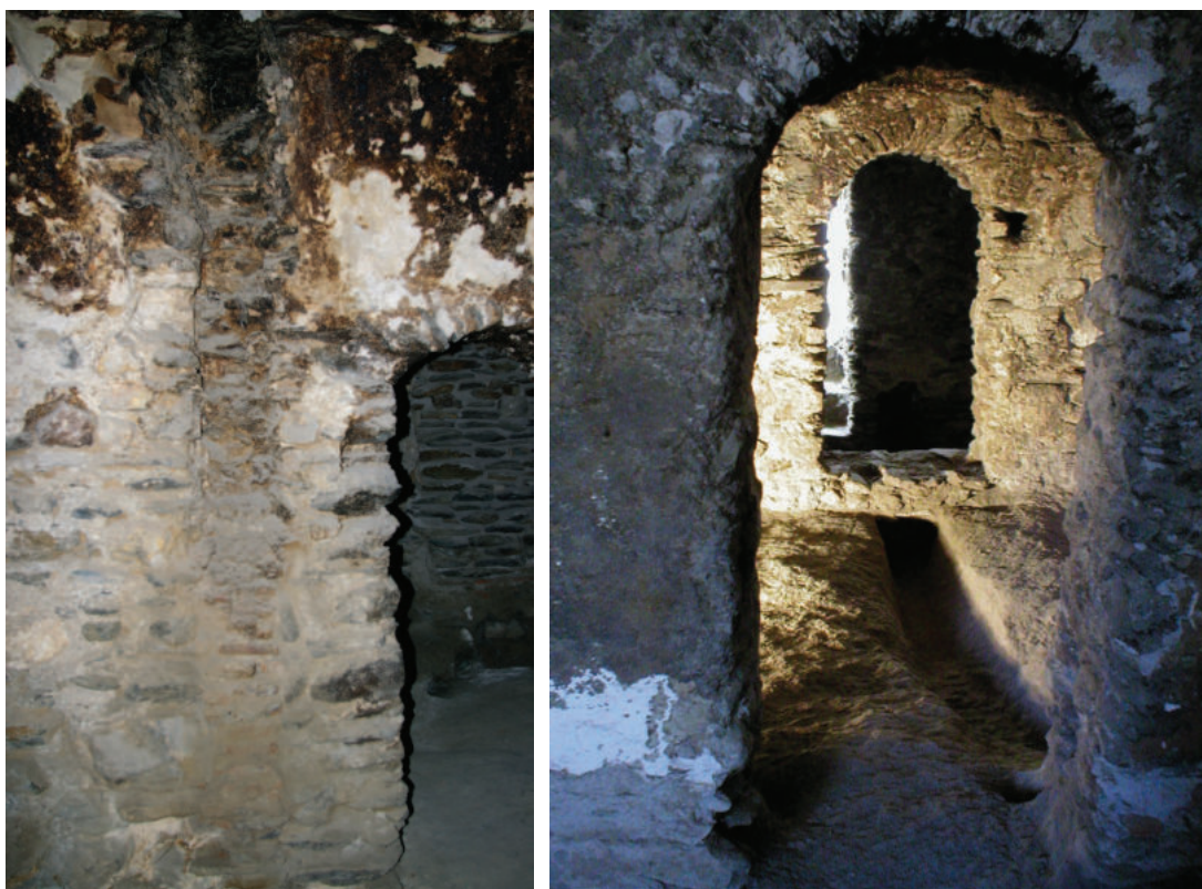
Láms. 18 y 19. Chimenea con detalle de enlucido original y pátina de hollín del incendio producido con ocasión de la rebelión de los moriscos. A la derecha, canalización excavada en la roca.
