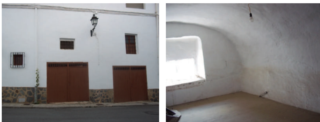
Láms. 8 y 9. Fachada de la vivienda donde se ubica el hipotético aljibe de los baños y detalle interior de una de sus naves. Cada puerta corresponde a una nave.
