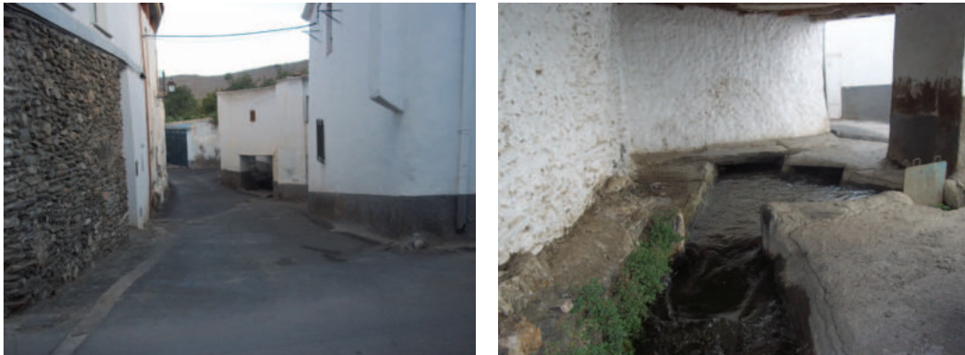
Láms. 10 y 11. Calle-cuesta que desciende de los baños (visibles por el muro de mampostería) a un porche donde reaparece el ojo de la acequia del Campo. A la derecha, imagen de este ojo de la conducción, que tras pasar bajo las viviendas ha servido de lavadero hasta quedar obsoleto y tal vez de desagüe del baño.
