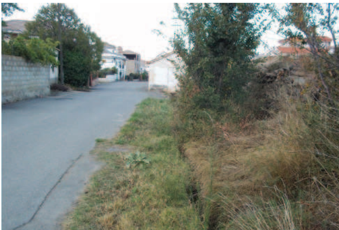
Lám. 6. Acequia del Campo a su entrada al pueblo, que circula bajo las viviendas.
