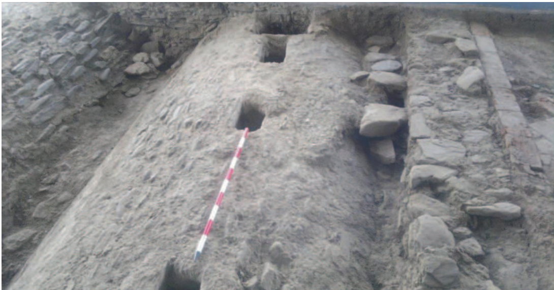
Lám. 5. Luceras de la sala templada vistas desde la primera planta del edificio, tras la excavación arqueológica del trasdós de las bóvedas. Foto: los autores.
