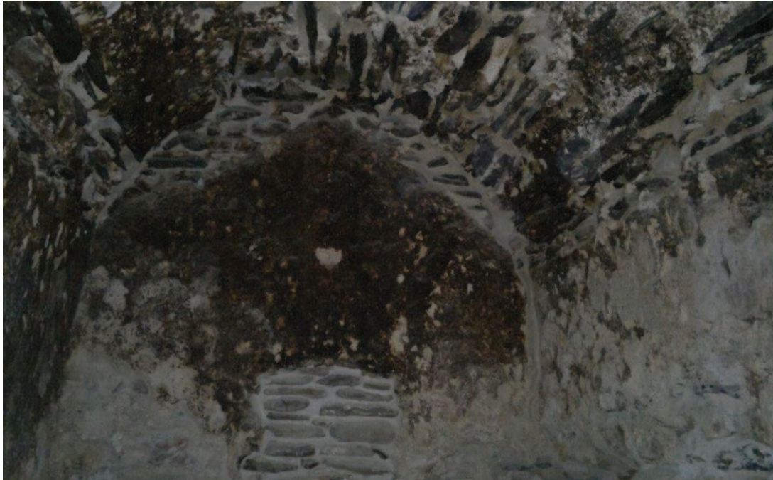
Lám. 3. Bóveda de cañón de mampostería que cubre la sala fría. Foto: los autores.
