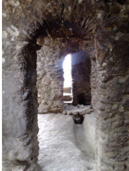
Lám. 8. Canaleta excavada en la roca y que unía el hipocausto de la sala caliente con una de las chimeneas de la sala templada, vista desde la sala fría. Foto: los autores.
