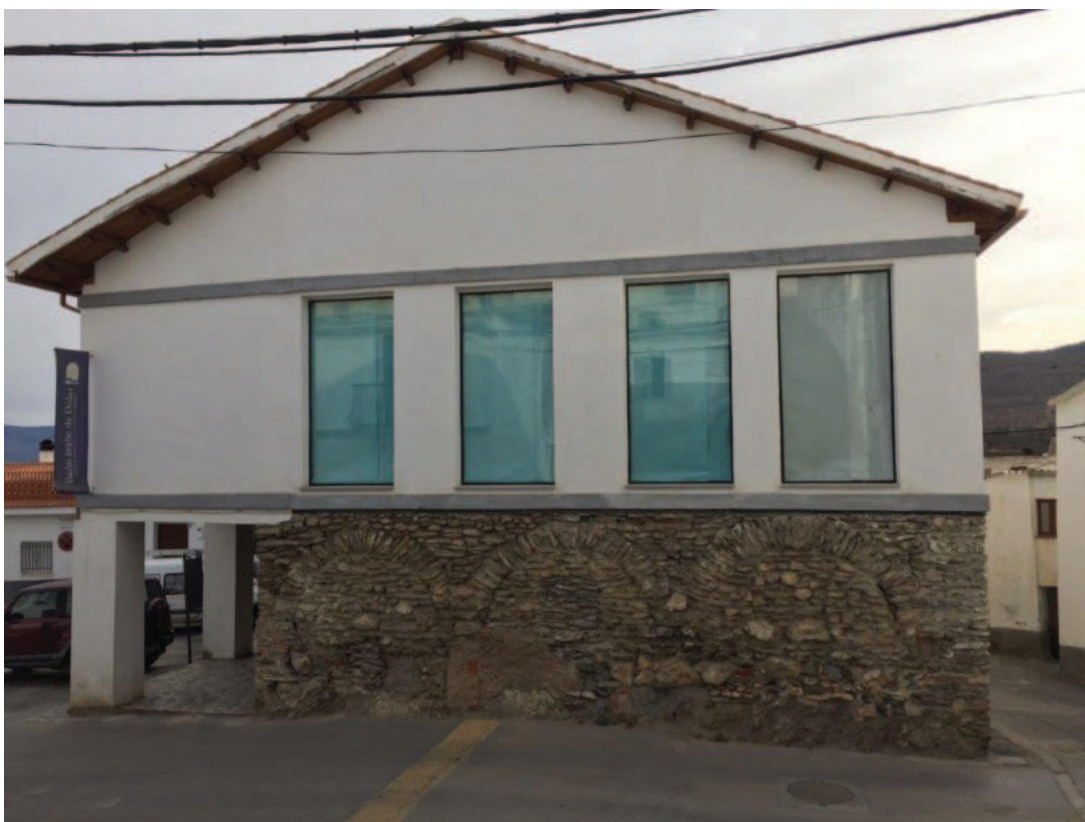
Lám. 15. Fachada lateral del baño, donde se aprecian las tres bóvedas del baño y los huecos del cerramiento de la primera planta que permiten la entrada de luz al interior del mismo a través de las lucernas. Foto: los autores.
