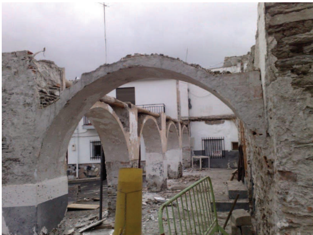
Lám. 9. Arcos de ladrillo a panderete que formaban la arquería de la antigua fachada principal del edificio. Foto: los autores.
