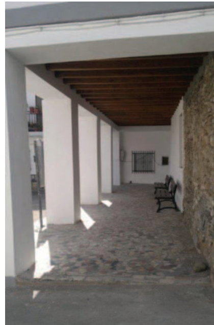
Lám. 11. Vista general del estado final de la galería. Foto: los autores.
