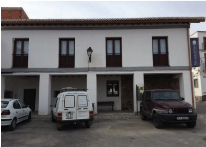
Lám. 10. Resultado final de la fachada que mira a la plaza. Foto: los autores.
