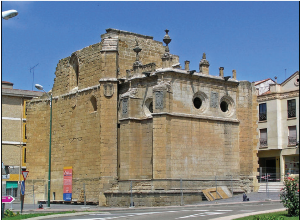
Lám. 1. Capilla de los Águila, en el ex convento de San Francisco (Ciudad Rodrigo).
