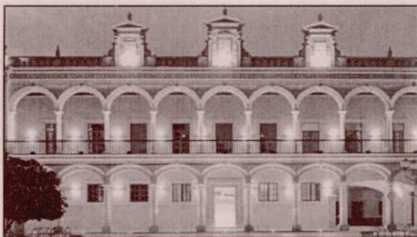
Ayuntamiento de Guadix, recientemente remodelado
