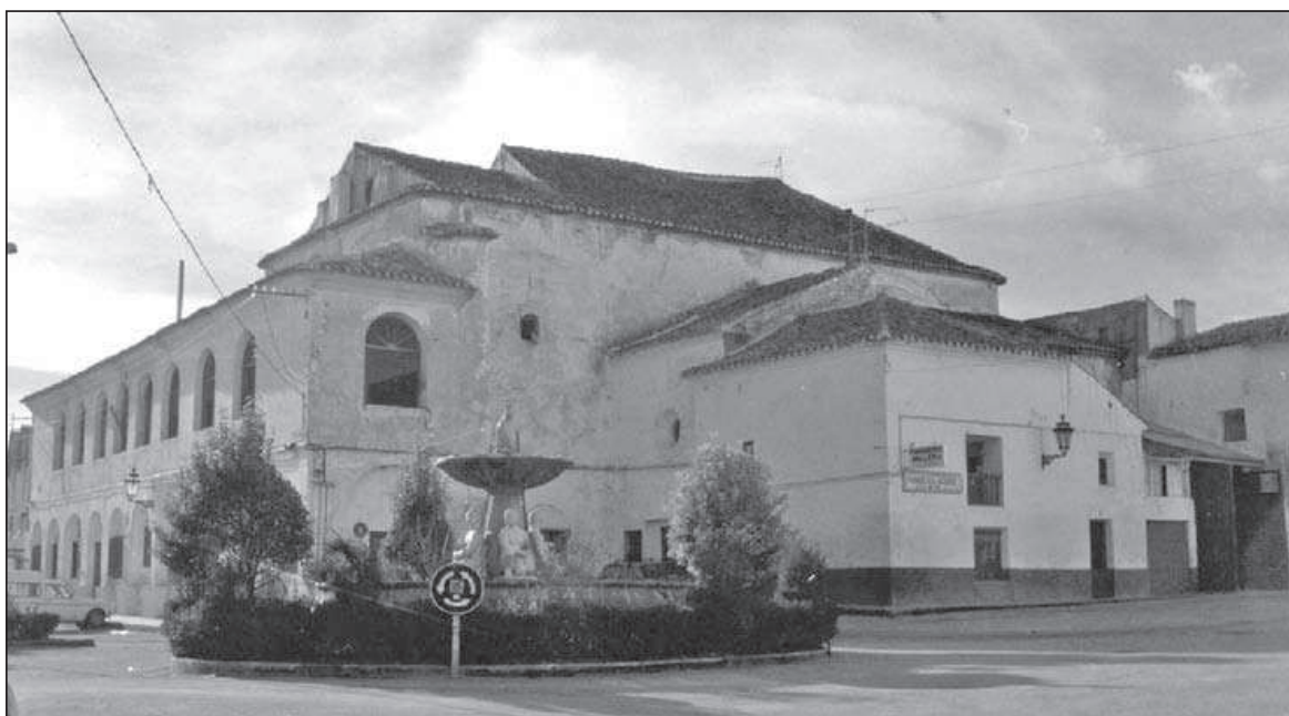
Otra perspectiva del Teatro Calderón, en la plaza de Cristo Rey de Puebla de Don Fadrique, a comienzos de los años 1990, poco antes de su demolición (cortesía de José Aguirre Sánchez).
