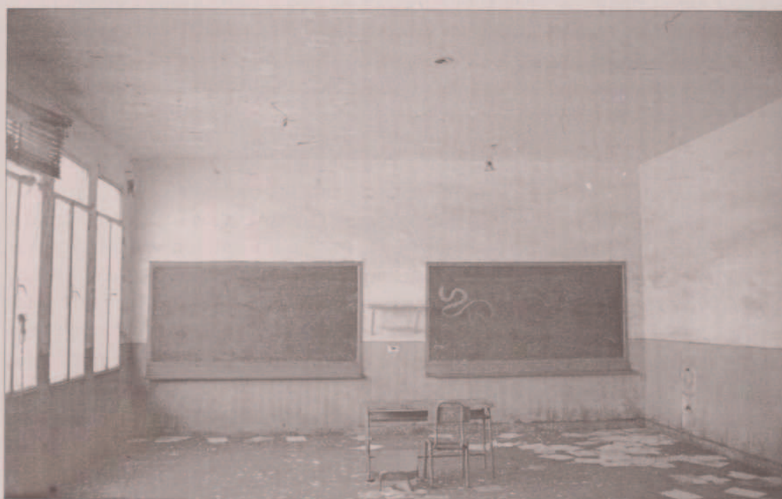
Estado actual del interior de la tercera Escuela.
