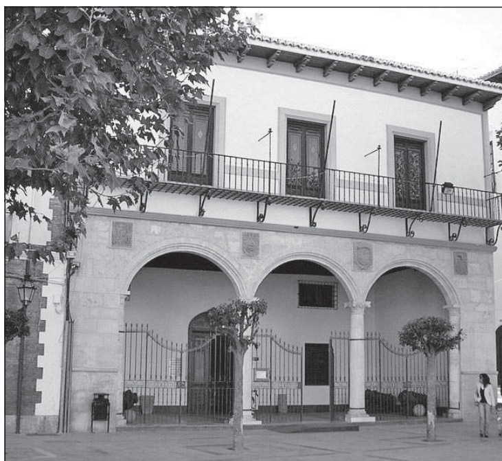
Antigua Casa de Cabildos de Baza.
