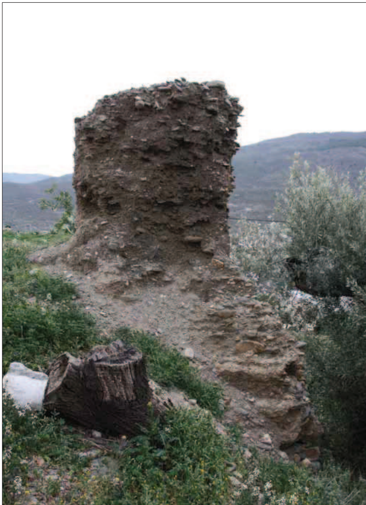
Fig. 6. Restos de una torre del castillo de Abia.
