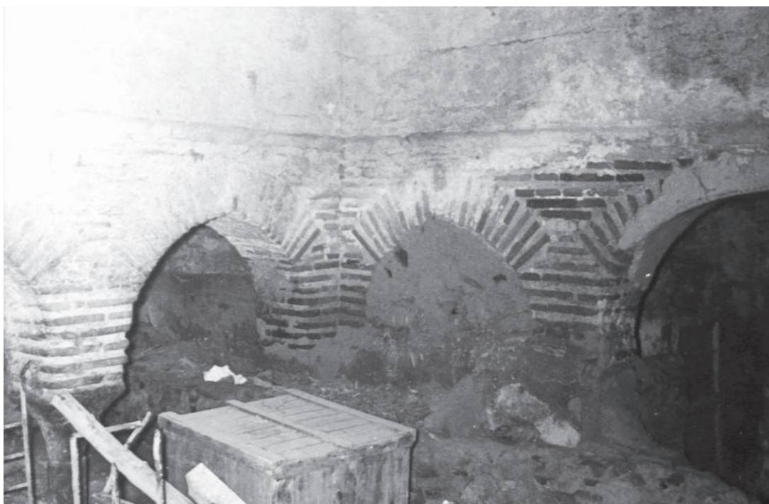
Lám. 1. Interior del wastani antes de acometer la primera intervención (hacia 1972).
