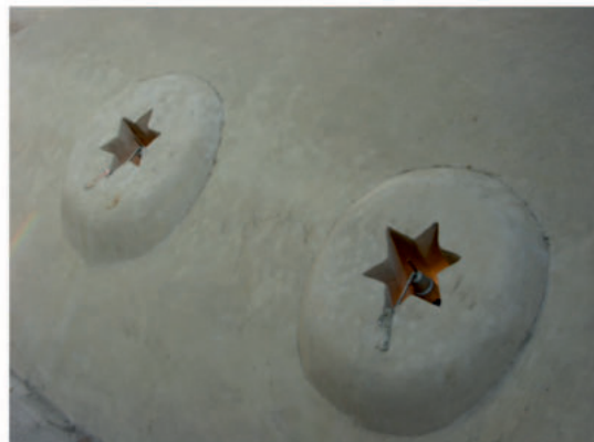
Láms. 13 a 16. Aspecto exterior de las lucernas durante el proceso de restauración y resultado final.
