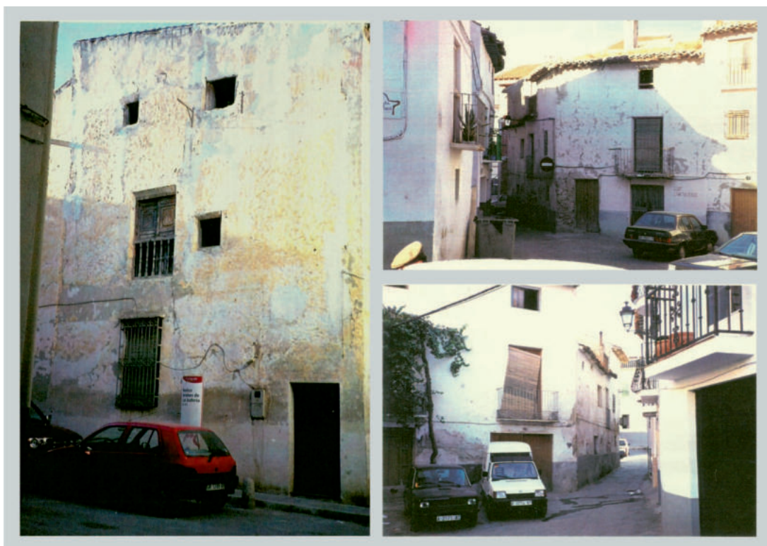
Láms. 4 a 6. Aspecto exterior de las viviendas construidas sobre el baño, antes de su demolición.
