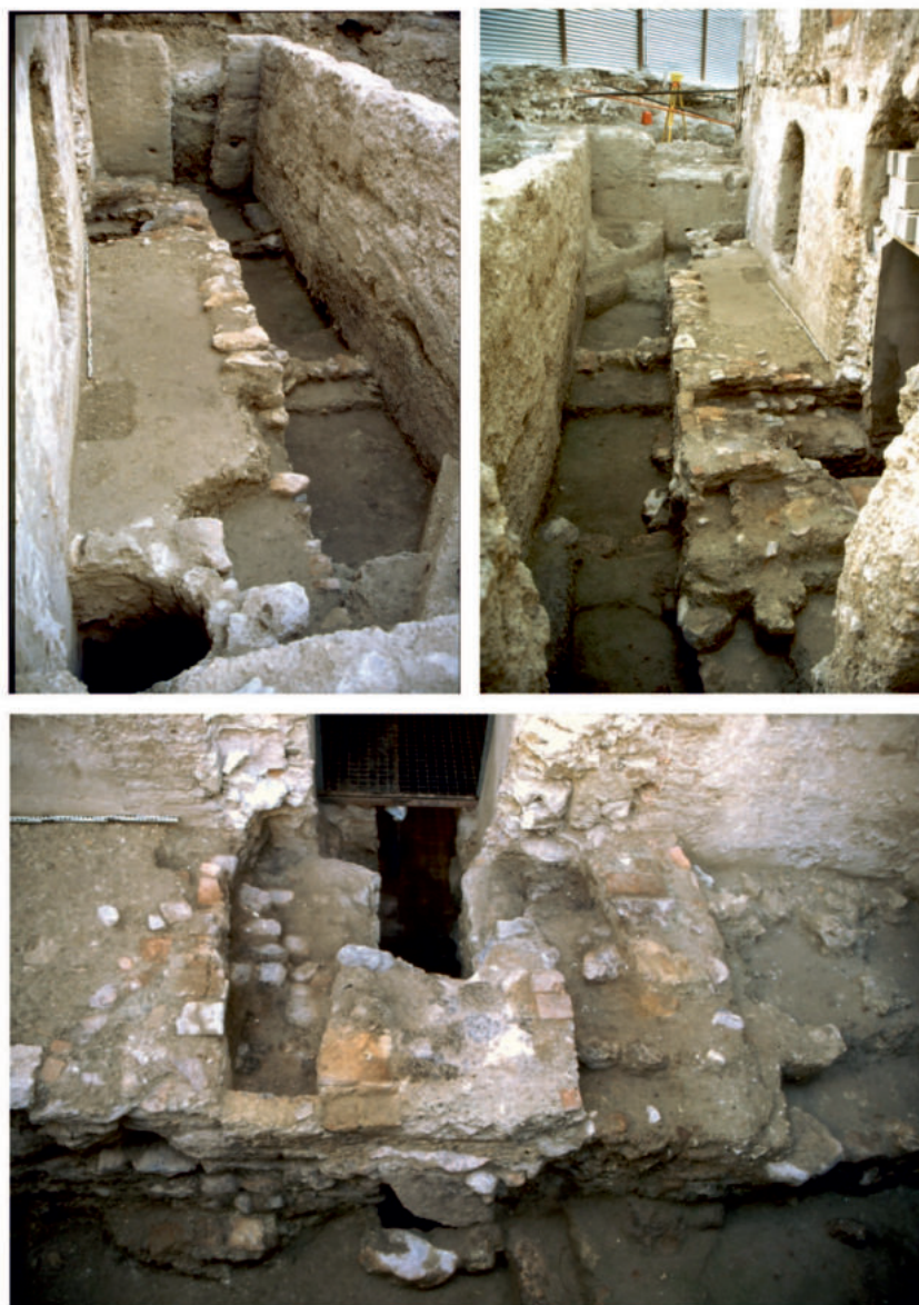
Láms. 7 a 9. Vistas del cuarto de la leñera y soporte de la caldera.
