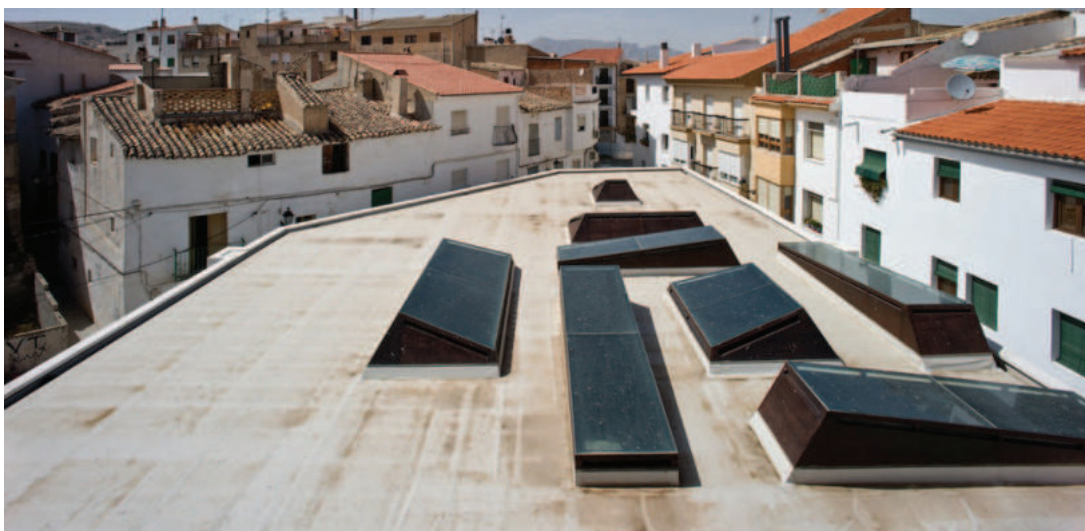
Lám. 25. Vista general de la cubierta del contenedor.
