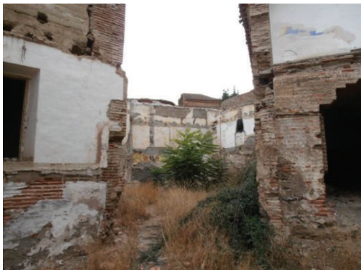
Fig. 32. Solar resultante del derribo de la casa nº 11 de la calle Ibáñez. Fotografía: Diego Fernández.
