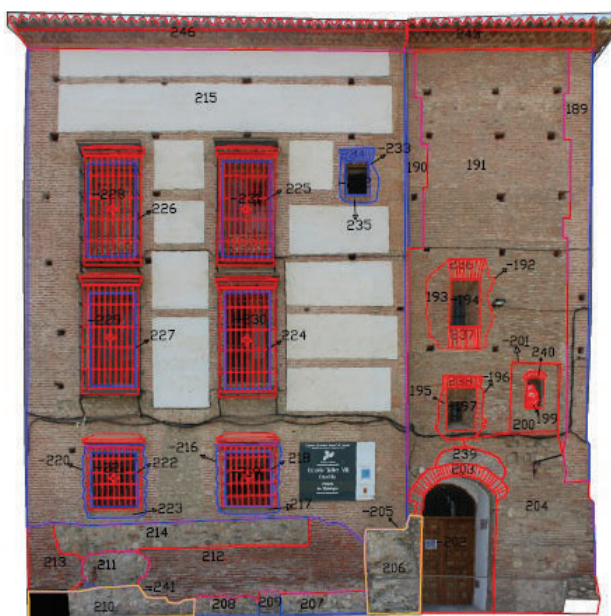
Fig. 13. Análisis estratigráfico de la fachada norte del palacio de Villaalegre. Fotografía y estratigrafía: Javier del Pozo.
