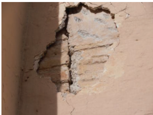
Fig. 26. Cerramiento de la nave. Fotografía: Diego Fernández
