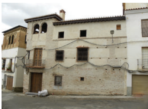
Figs. 17, 18 y 19. Estado previo, durante y posterior a la rehabilitación de la casa de la calle Duende nº 9. Fotografías: Javier del Pozo.
