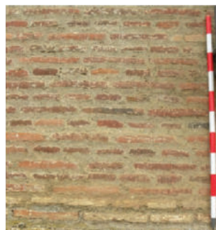
Figs. 7 y 8. Aparejo belga en la fachada oeste del palacio de Villaalegre.
