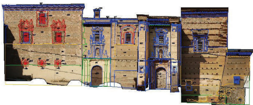
Fig. 25. Análisis estratigráfico de la fachada este del convento de la Concepción. Fotogrametría y estratigrafía: Javier del Pozo.
