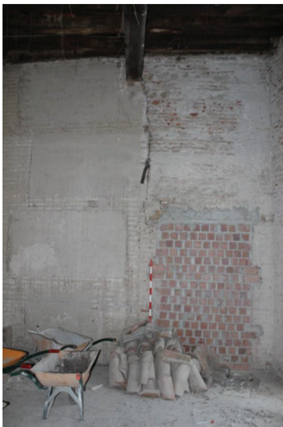
Fig. 10. Habitación ampliada en la parte norte del palacio de Villaalegre. Fotografía: Javier del Pozo.
