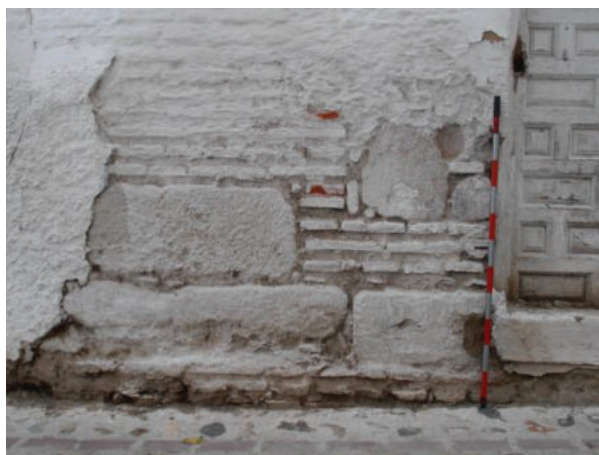
Fig. 30. Zarpa de cimentación de la casa de la calle Ibáñez nº 1. Fotografía: Diego Fernández.
