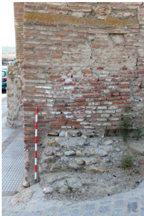
Fig. 5. En la fachada oeste, donde se puede observar la sección de la muralla medieval, soportando el muro de ladrillos. Fotografía: Javier del Pozo Vilá.
