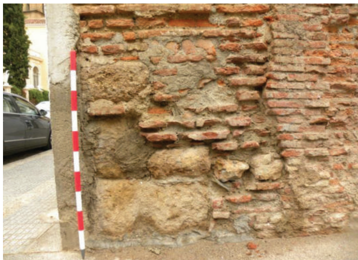
Fig. 14. Sillares de arenisca en la esquina oeste del antiguo Hospital Real. Fotografía: Javier del Pozo.
