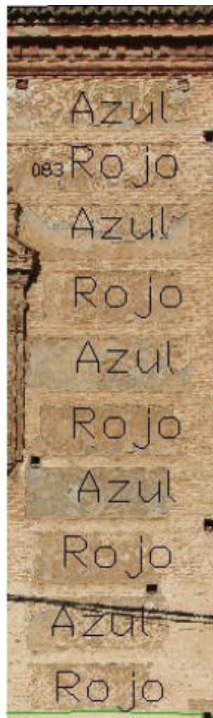
Fig. 24. Esgrafiado en los cajones alternando colores. Fotografía: Javier del Pozo.
