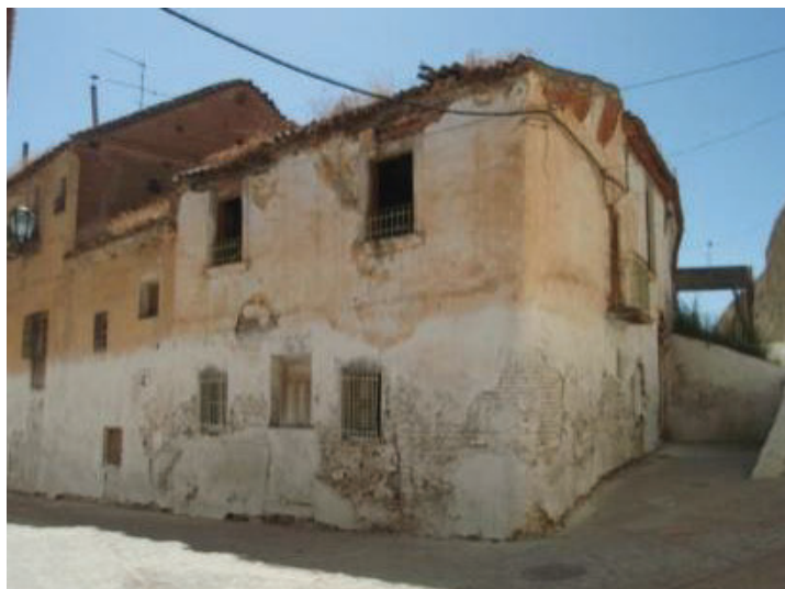
Fig. 31. Casa de la calle Ibáñez, antes de su derribo. Fotografía: Iratxe Bravo.
