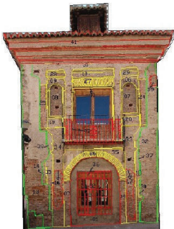
Fig. 16. Análisis estratigráfico de la fachada oeste del Hospital Real. Fotogrametría y estratigrafía: Javier del Pozo.
