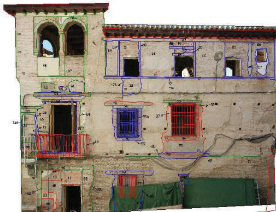
Fig. 21. Análisis estratigráfico de la fachada oeste de la casa de la calle Duende nº 9. Fotogrametría y estratigrafía: Javier del Pozo.
