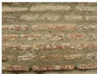
Fig. 6. Aparejo inglés en la fachada sur del palacio de Villaalegre.
