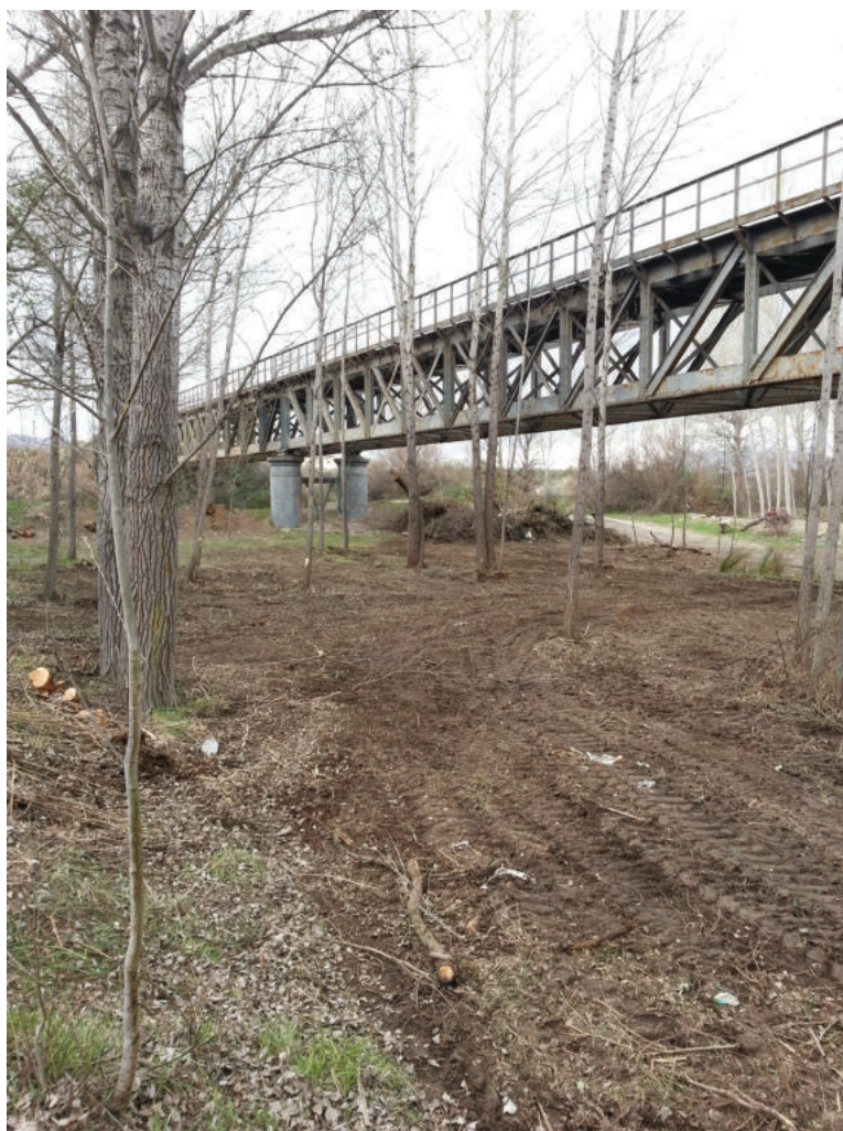
Lám. 9. Puente de hierro de Caniles. Foto: Archivo fotográfico de Armuña Geographic.
