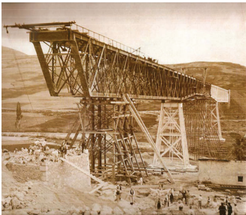
Lám. 8. Puente de Gor en construcción. Foto: Archivo fotográfico de Armuña Geographic.
