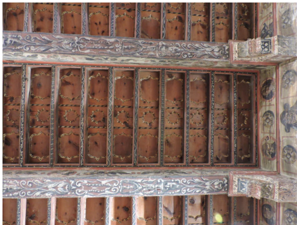
Lám. 2. Tablazón. Labor de menado con alfarzones y chillas. Foto: los autores.
