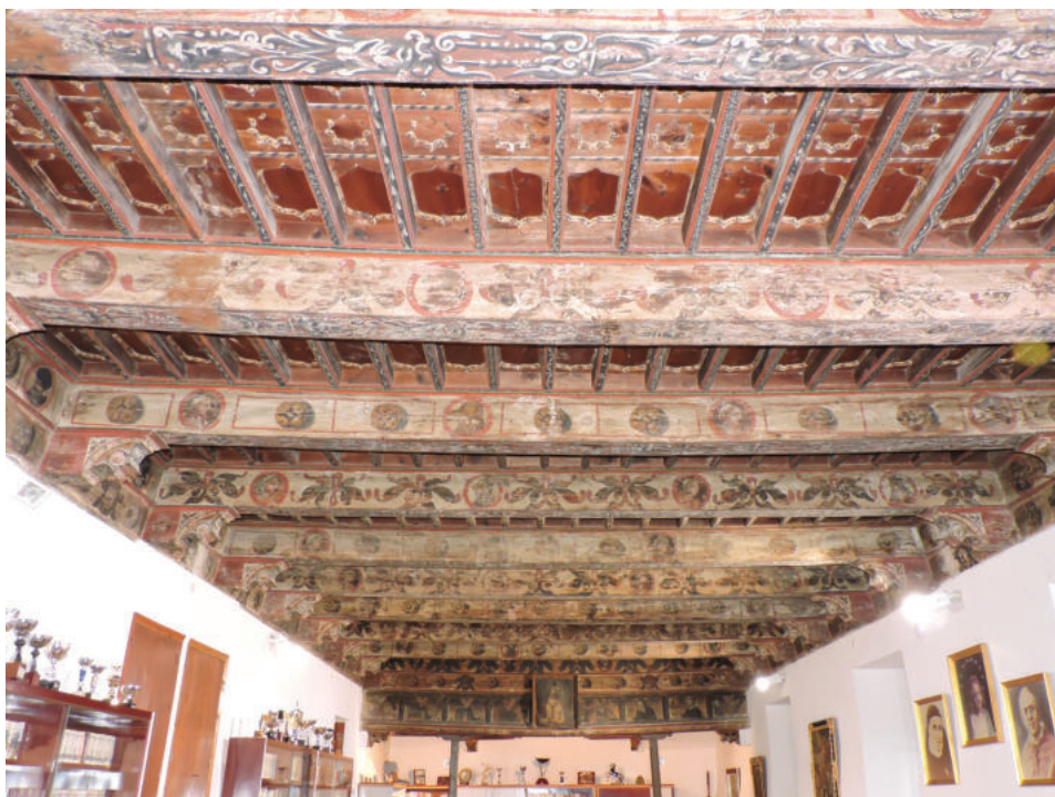
Lám. 1. Vista general de la techumbre del cuarto de la enfermería. Foto: los autores.
