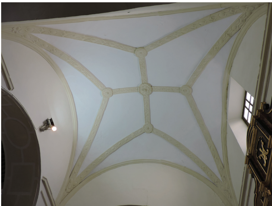
Lám. 3. Bóveda de la capilla de Francisco de Arenas. Foto: los autores.
