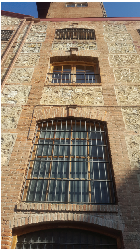
Lám. 16. Detalle de la fachada sur de la nave de turbinas. Foto: Miguel Ángel Sánchez Gómez (2019).
