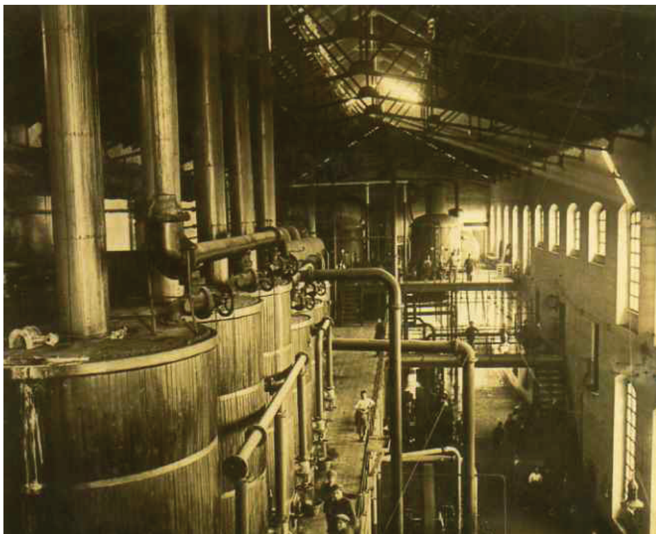
Lám. 4. Secciones de carbonatación y evaporación. Fuente: Archivo Manuel Rosillo Herrera.
