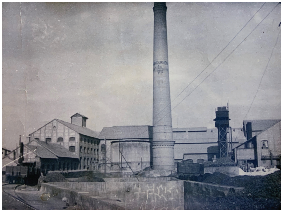
Lám. 8. Silos de carbón. Fuente: Archivo Manuel Rosillo Herrera.
