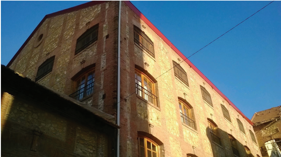
Lám. 14. Parte alta del antiguo almacén de útiles. Foto: Miguel Ángel Sánchez Gómez (2019).
