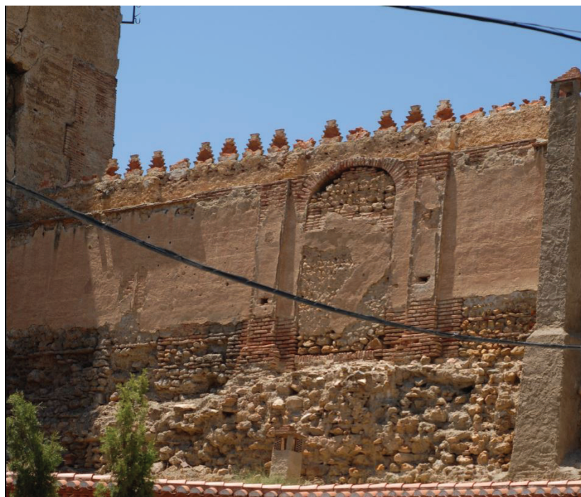
Fig. 8. Imagen de la puerta napoleónica antes de su derribo (Rouco et al., 2018).
