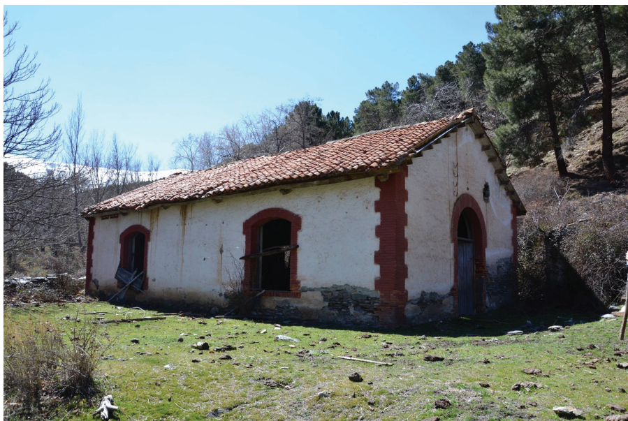
Lám. 14. Casa de máquinas de la central de Alcázar Foto: del autor.
