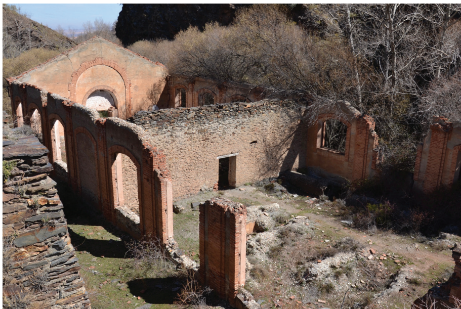
Lám. 11. Estado actual en el que se encuentra la casa de máquinas de la central. Foto: del autor.
