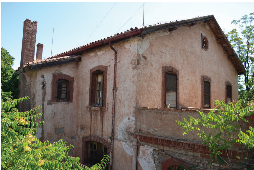
Lám. 23. Casa de Mr. Barret y oficinas en las minas de Alquife. Foto: del autor.
