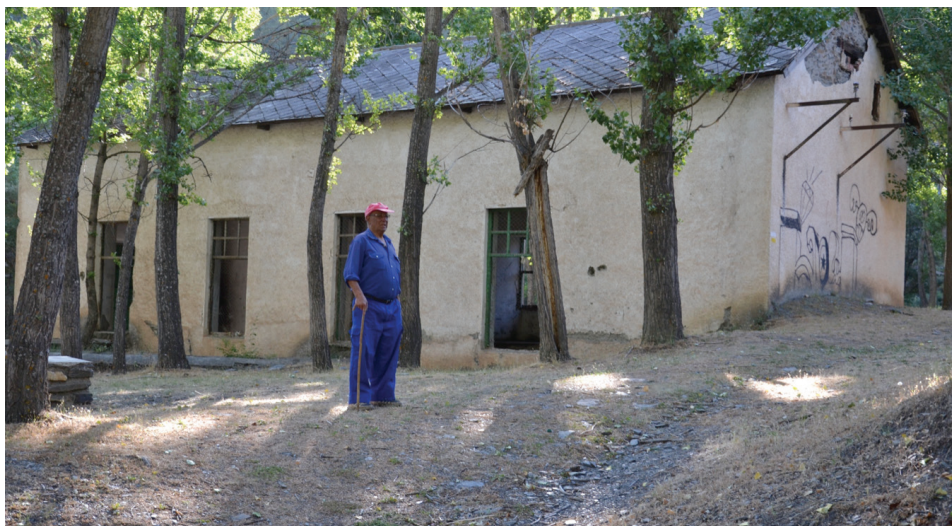
Lám. 21. Casa de máquinas de la central hidroeléctrica del Sabinar, con uno de sus maquinistas, Manuel el Rata. Foto: del autor.
