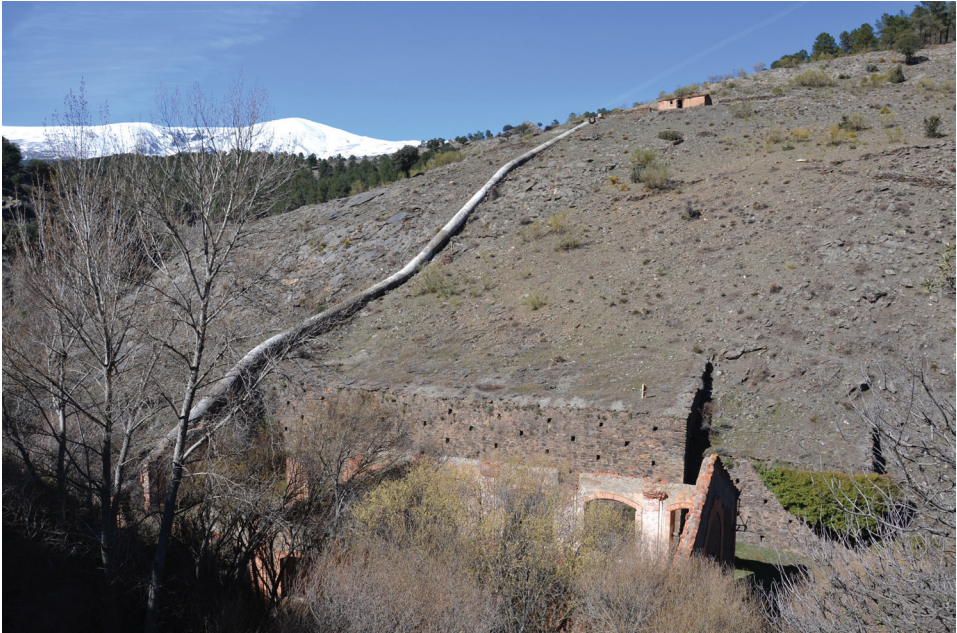
Lám. 9. Central de aire comprimido, estado actual 2018. Foto: del autor.
