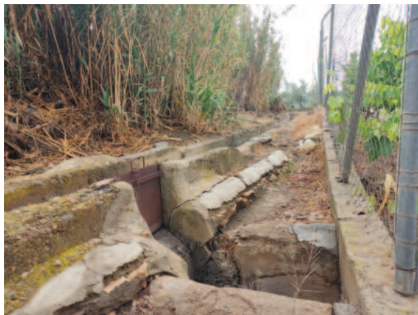
Lám. 19. Partidor construido con cemento. Foto: María Bastida Malo.
