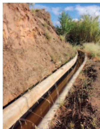
Lám. 28. Tramo de cemento. Foto: María Bastida Malo
