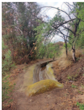
Lám. 29. Tramo entubado. Foto: María Bastida Malo.
