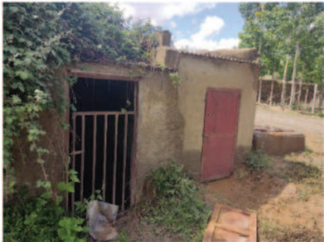
Lám. 8. Zona de acceso al interior de la tajea de la acequia de la Ciudad. Foto: María Bastida Malo.
