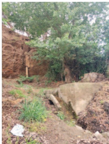
Lám. 20. Sifón en la rambla de Don Víctor. Caída de agua y depósito. Foto: Paula Ramón Carmona.
