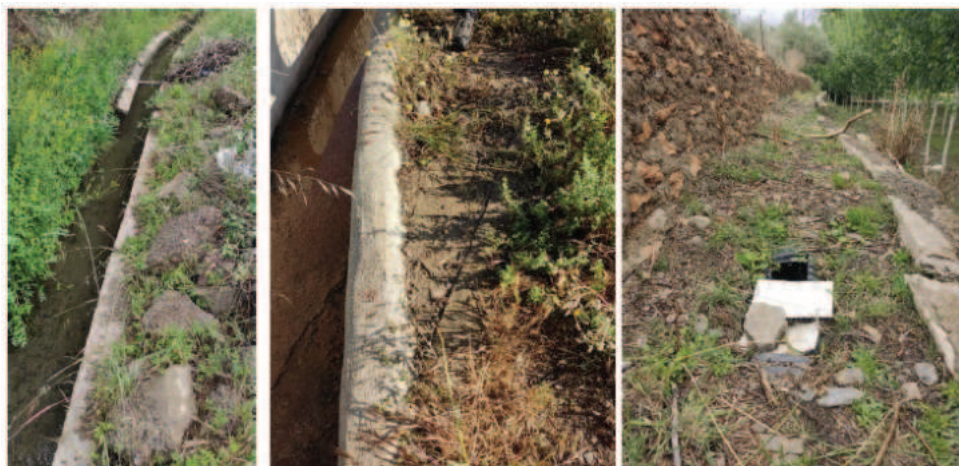
Lám. 15. Restos de la estructura anterior de la acequia madre tras haber sido reparada. Foto: Paula Ramón Carmona.
