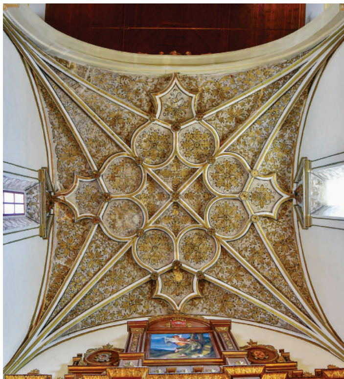
Fig. 11. Bóveda gótica con decoración barroca en la capilla mayor de la antigua iglesia de la Merced de Baza. Foto: Juan M. Segura.
