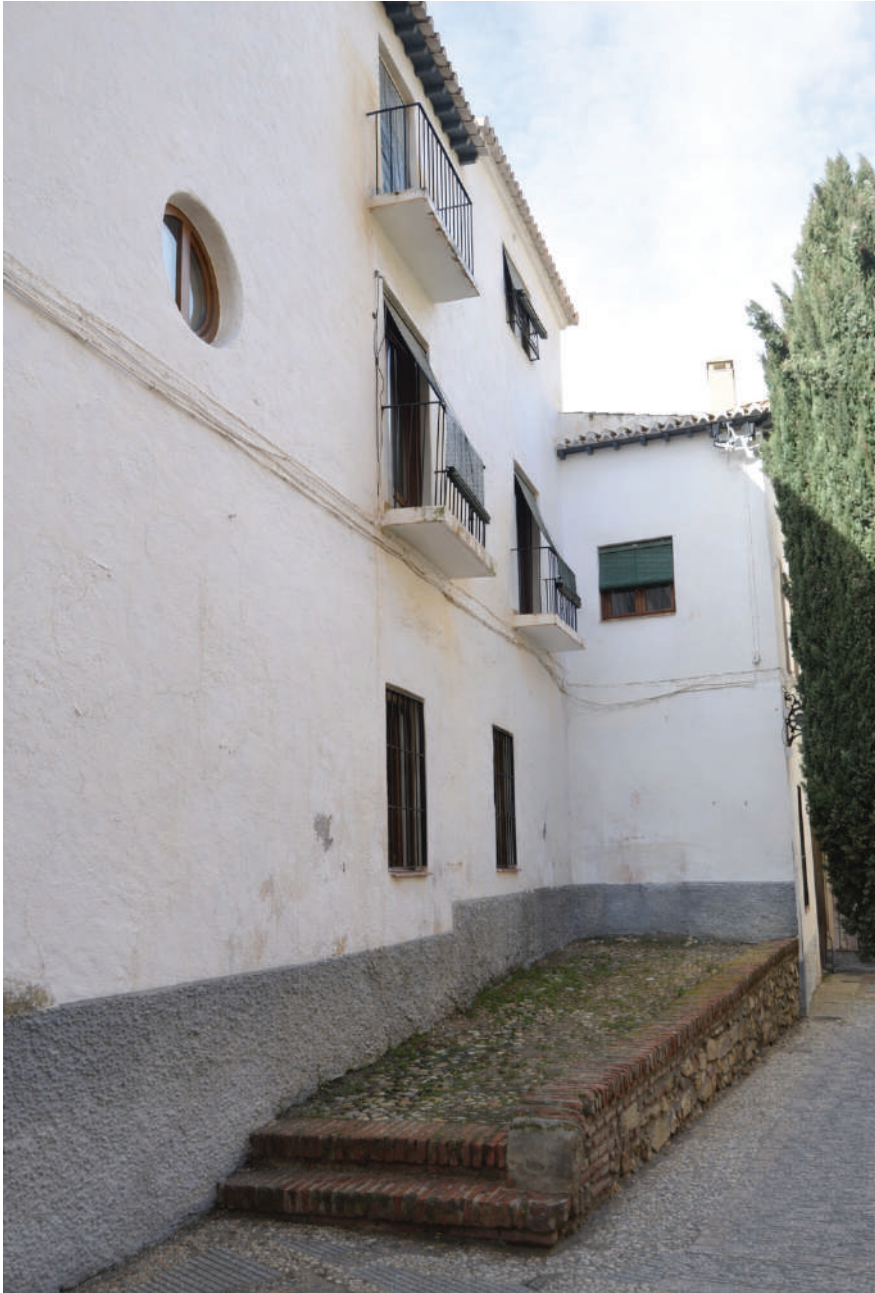
Fig. 7. Segundo emplazamiento del pilar del Cañillo, en la calle Santa María del Buen Aire (Guadix). Foto: José M. Rodríguez Domingo.
