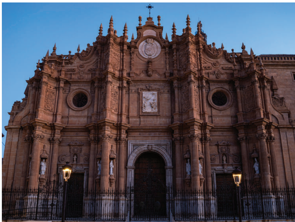
Fig. 2. Fachada de la Encarnación de la S.A.I. Catedral (2024). Foto: Leo Lázaro.
