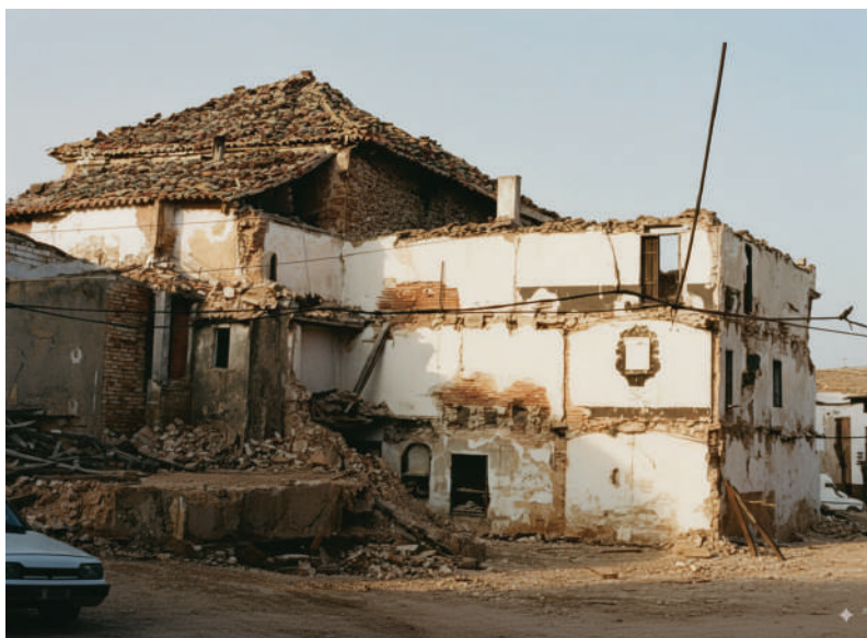
Fig. 13. El antiguo convento de Puebla de Don Fadrique, durante el proceso de demolición (1991). Foto: Jesús Rubio.
